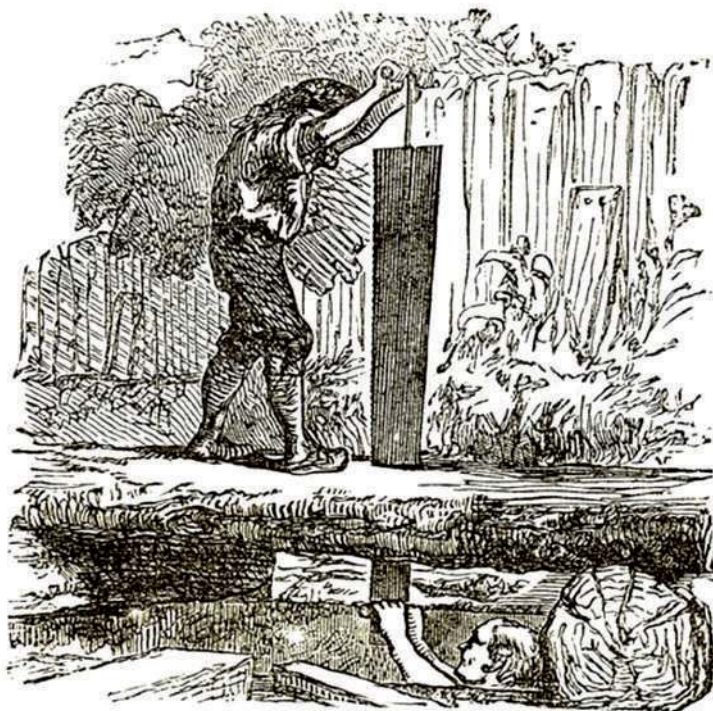
Obr. 1.02 Ruční výroba řeziva (v současnosti označovaná jako pit-sawing nebo up-down sawing a dosud běžně používaná v rozvojových zemích)
