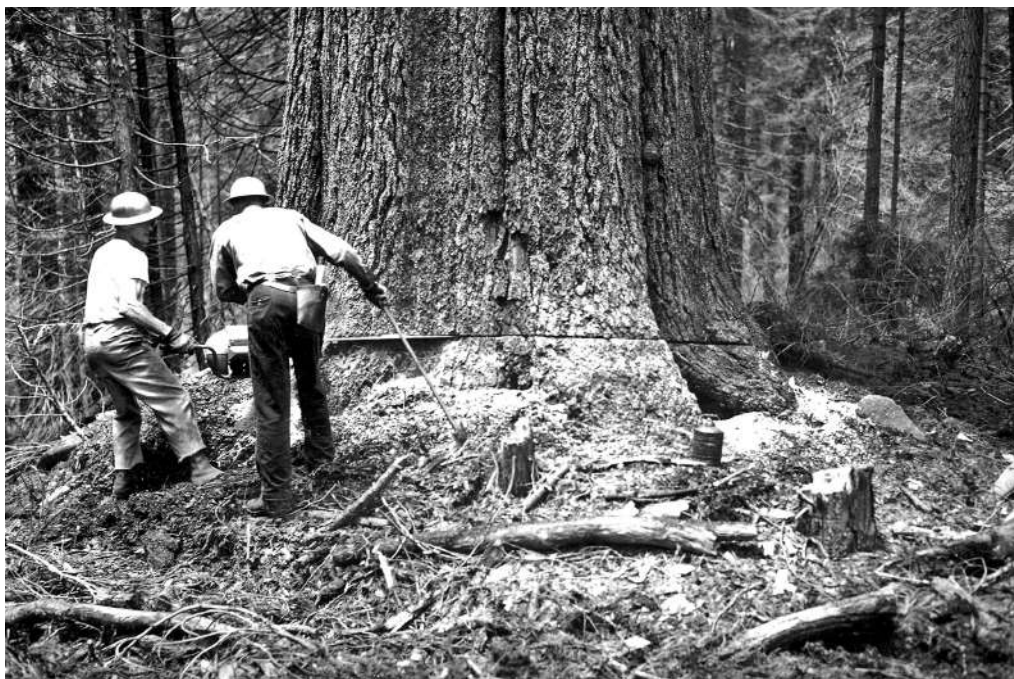
Obr. 1.12 Dvoumužná řetězová pila Disston Mercury kolem roku 1955
