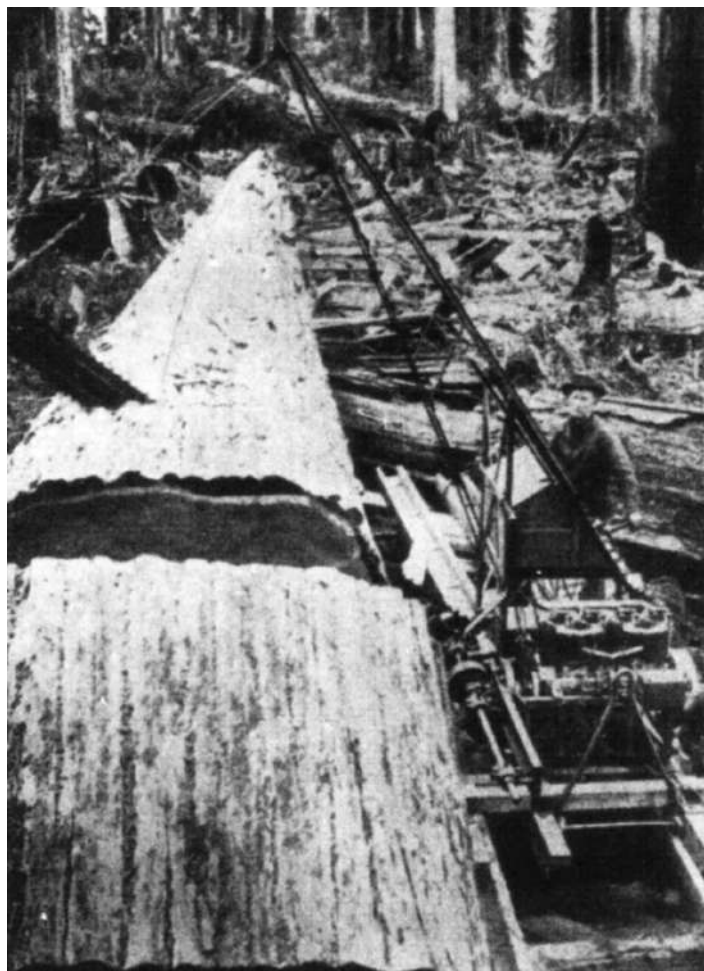
Obr. 3.14 Muirova zkracovací řetězová pila v terénu (1910)
