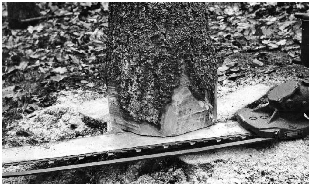
Obr. 3.16 Detail sekacího řetězu a ochranné lišty, kolem roku 1950
