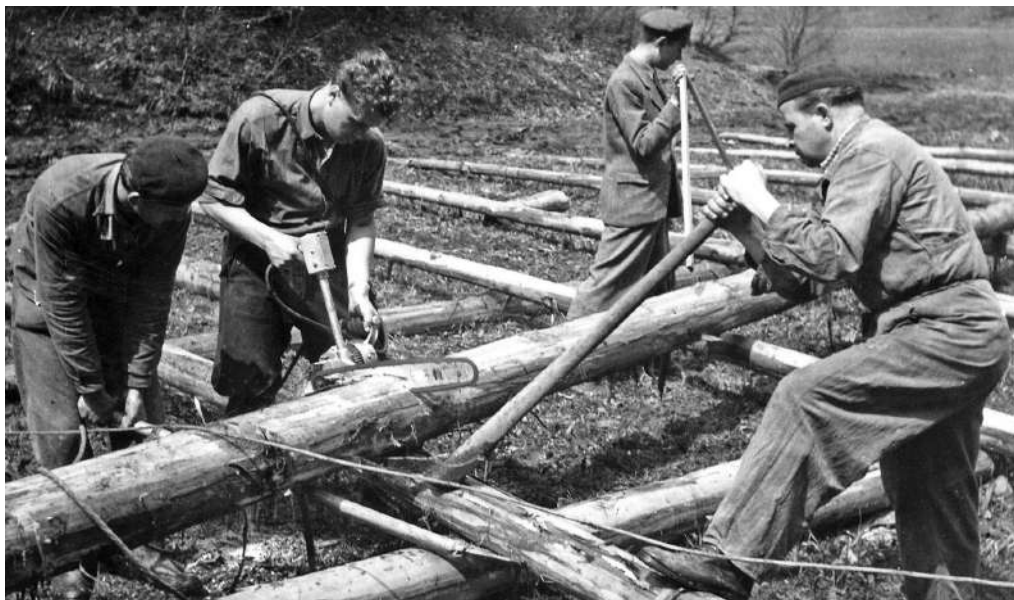
Obr. 4.99 Elektrická pila CNIIME K 5 byla ve své době nejlehčí motorovou pilou
