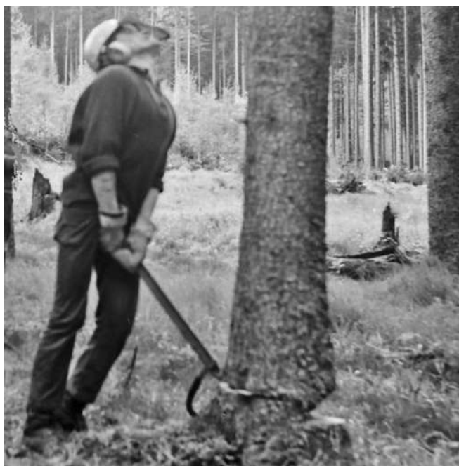
Obr. 5.03 Dřevorubecké přetlačovací lopatky s obracákem Lopatky umožňovaly a usnadňovaly práci samostatně pracujícího dřevorubce. Foto Vladimír Simanov, 1972.
