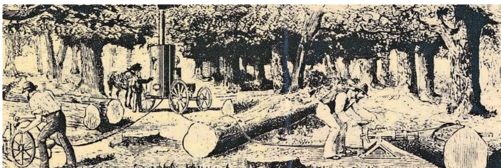
Obr. 4.49 Parní řetězové pily Ransome zásobované párou z lokomobily (portable steam engine)
