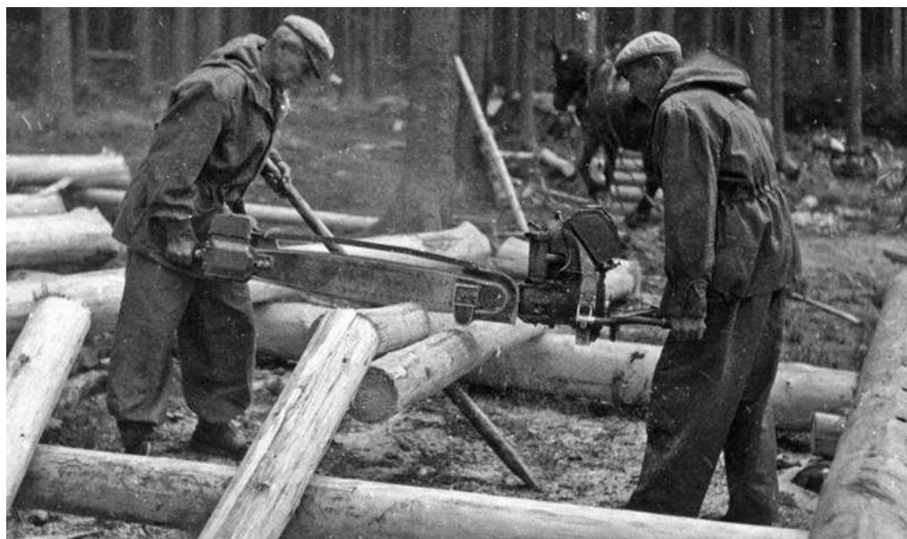
Obr. 5.08 Použití dvoumužné motorové pily MP-50 na horním skladě
